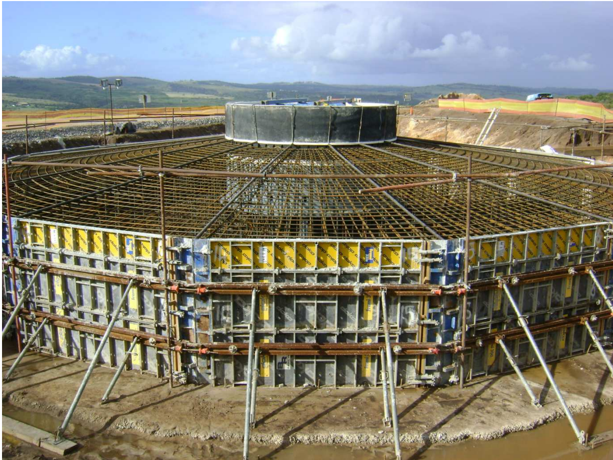
Turbine foundation ready for concrete pour
